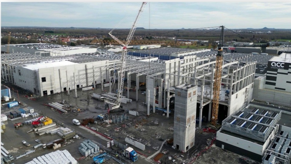
GIGAFACTORY ACC DOUVRIN - 60 000 M 2 · RÉALISATION BEMACO
