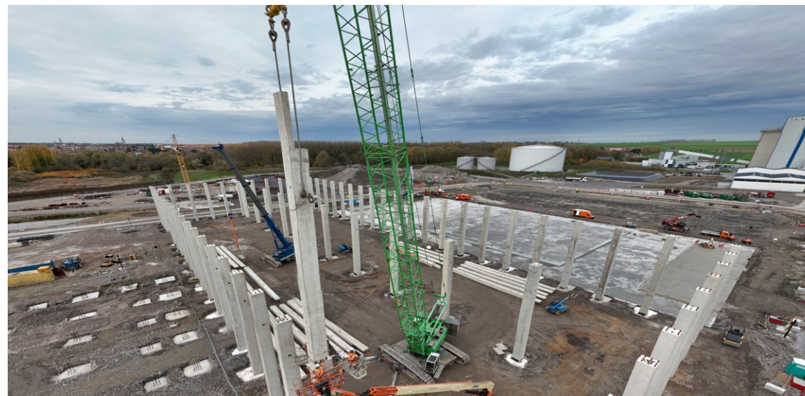
CHANTIER 2025 - GRUE LIEBHERR · CHARPENTE BÉTON
