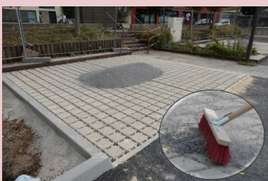
RÉALISATION DES JOINTS*
