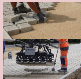
POSE DES PAVÉS MANUELLE OU AVEC PINCE
