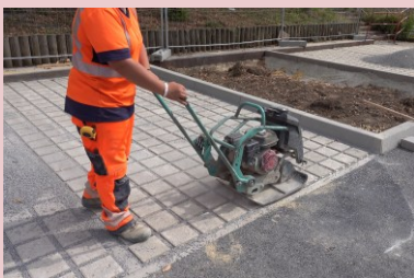
COMPACTAGE DES JOINTS
