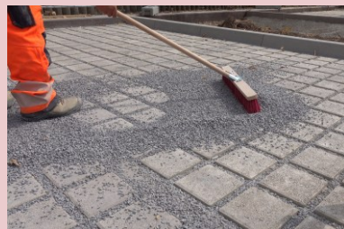
GARNISSAGE FINAL DES JOINTS
