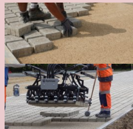
POSE DES PAVÉS MANUELLE OU AVEC PINCE
