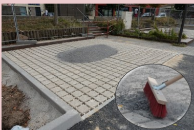
RÉALISATION DES JOINTS*
