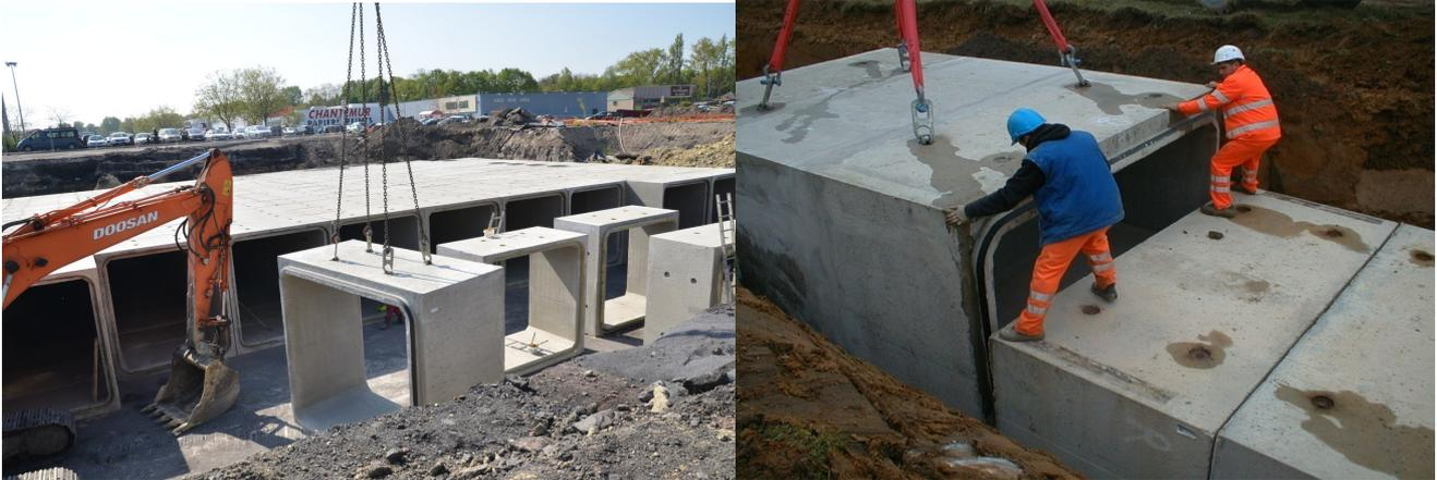
Mise en place du cadre à l'aide de la grue pour le positionnement de l'emboîtement
