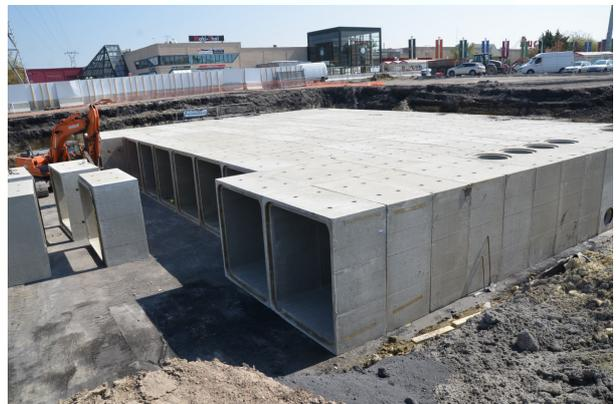
Fond de fouille stabilisé sable et ciment sec mélangés
