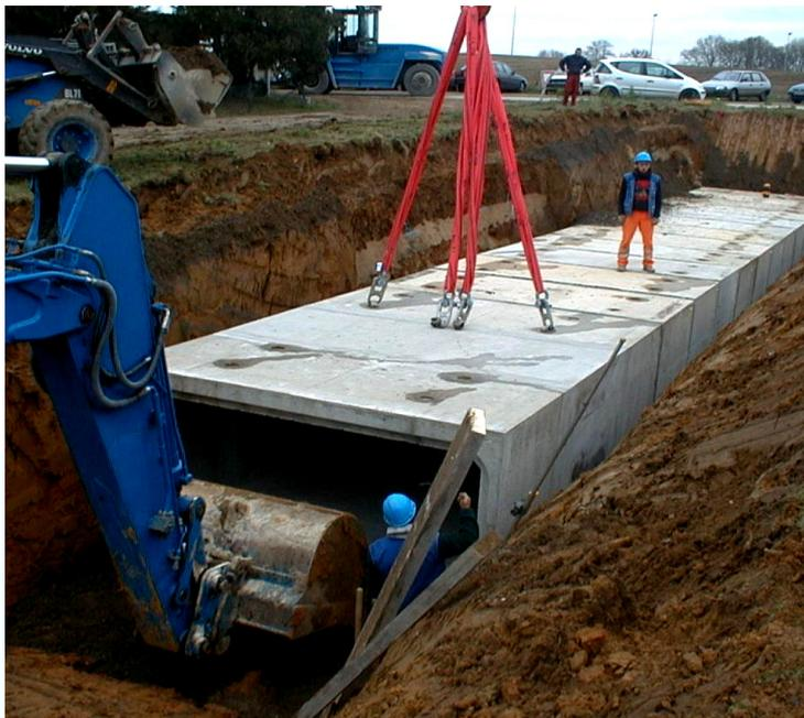
Emboîtement du cadre à l'aide d'une pelle hydraulique avec la mise en place d'une cale martyr entre le cadre et le godet.
